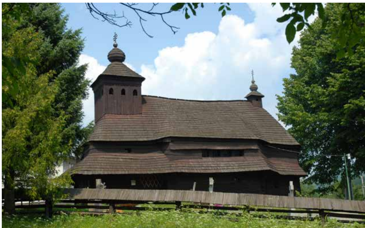
Ulickie Krive (Park Narodowy „Poloniny” – słowacka część MRB „KW”). Cerkiew greckokatolicka pw. św. Michała Archanioła, 1718 r.
