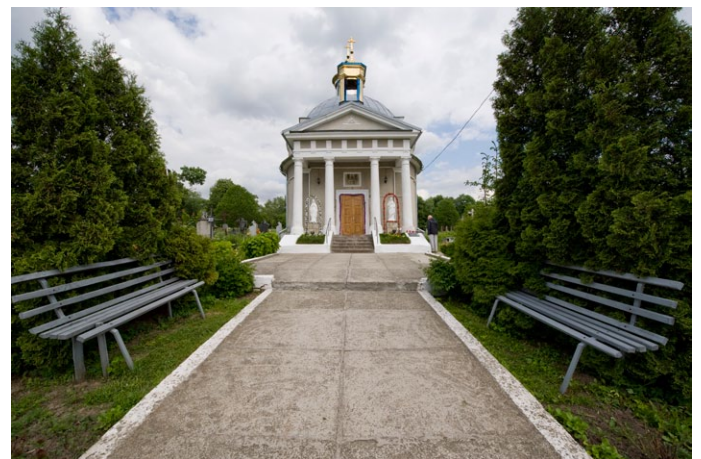
Odremontowana kaplica Potockich na cmentarzu w Monastyrzyskach.
