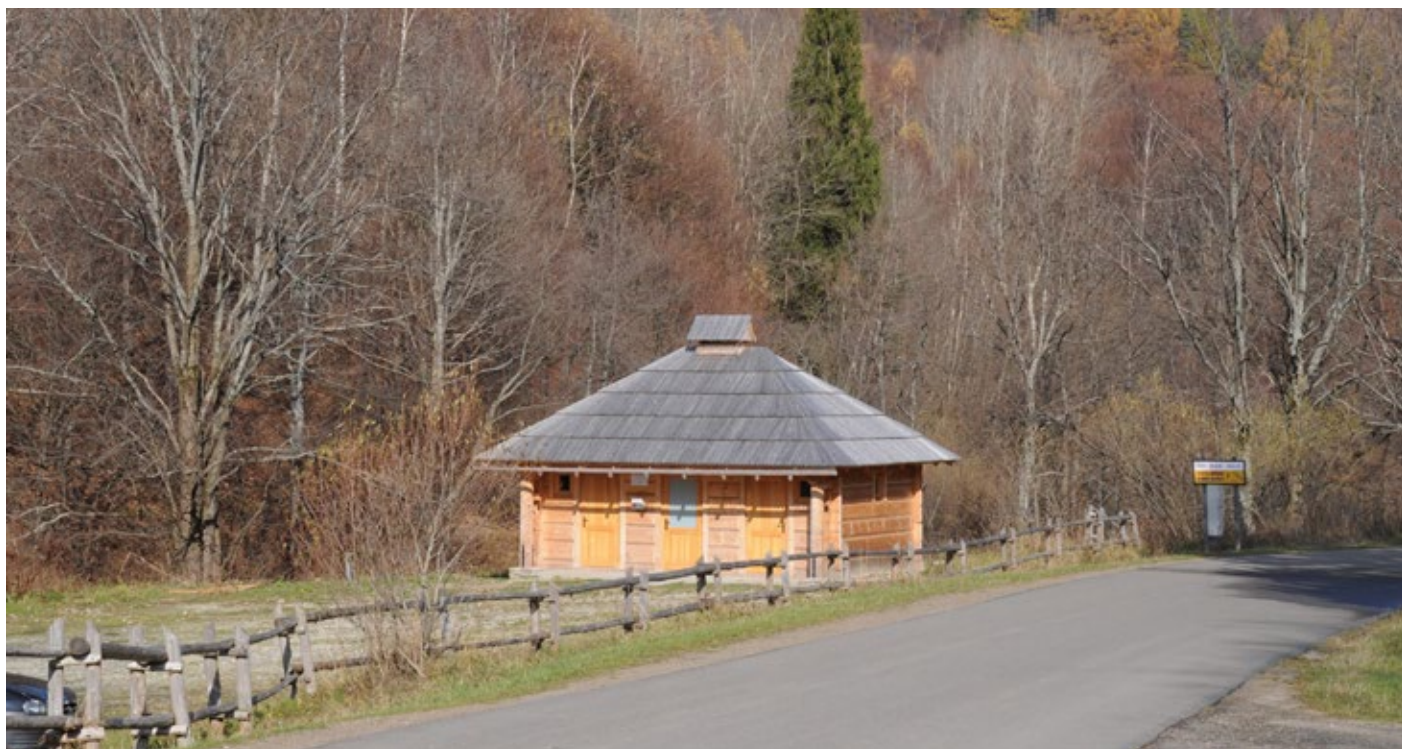
Duży obiekt sanitarny.
