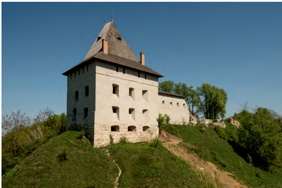
Fot. 35. W Haliczu, na bazie starych ruin, zrekonstruowano zamek wybudowany w XIV wieku za króla Kazimierza Wielkiego.
