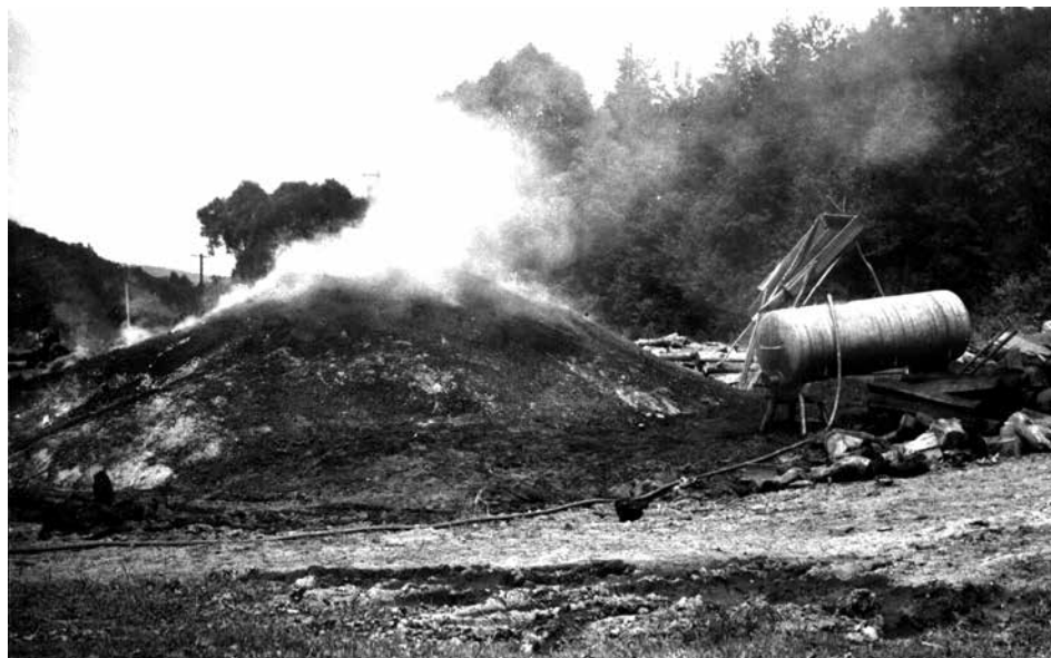
Ryc. 3. Wygaszony, stygnący mielerz (Fot. E. Miśkowiec).
